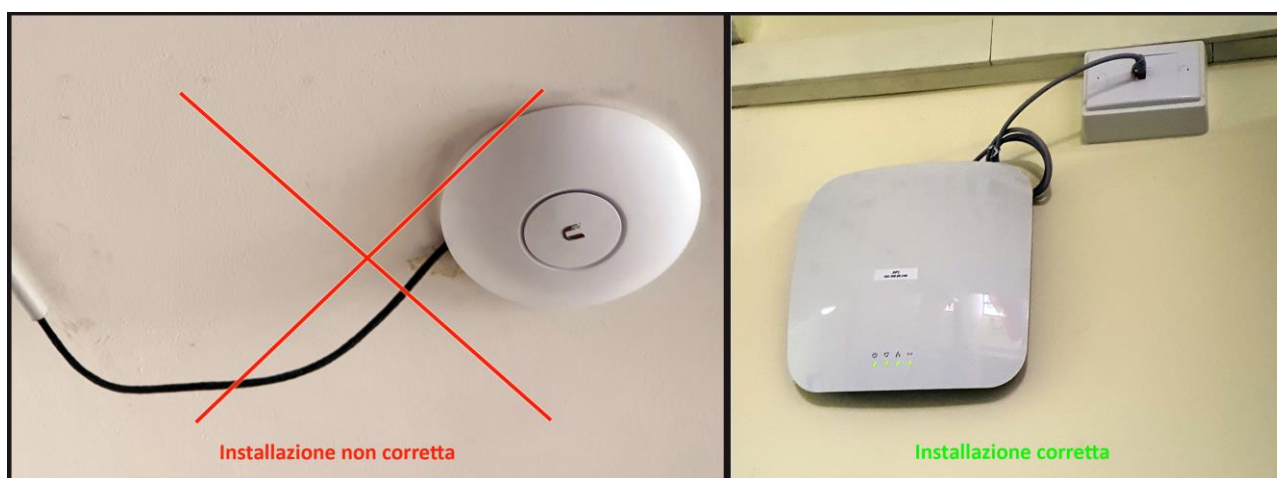
Figura 10 – Installazione corretta dell'Access Point
