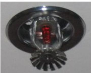
Erogatore sprinkler con elemento termosensibile a bulbo di vetro
